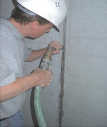
Das Vergumat Fugensystem ist die wirtschaftliche Lösung wenn es um das kraftschlüssige verschließen von senkrechten und waagerechten Betonfertigteifugen und das brandschutztechnische vermörteln von Feuerschutztüren, Brandschutzklappen, Lüftungsleitungen und Rohrdurchführungen geht.
